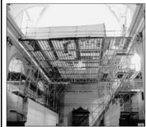
I ponteggi eretti nel duomo per i restauri (foto Pecora)
