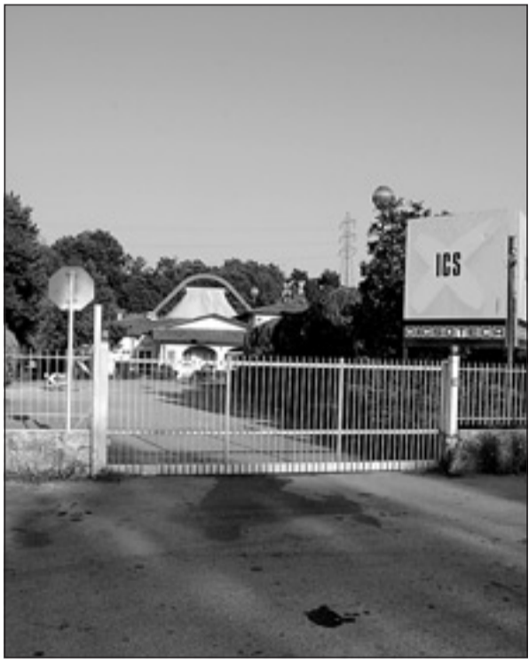
L'ingresso dell'Ics: la discoteca verrà presto demolita
